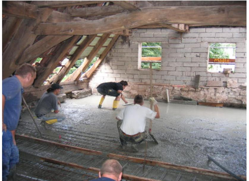
**Betonieren der Betondecke am Kühlschiff**
